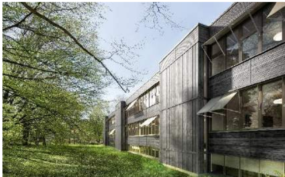
SCHULANLAGE LOOREN, ZÜRICH Gesamtinstandsetzung
