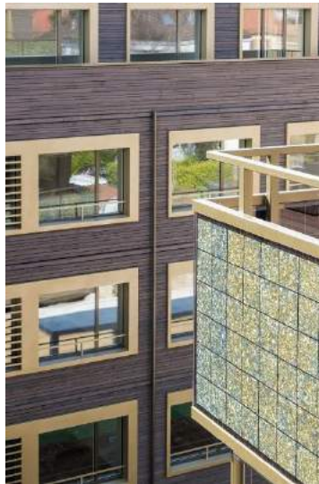
ZWYSSIGSTRASSE, ZÜRICH-ALTSTETTEN Holzbau Mehrfamilienhaus mit PV-Balkongeländer
